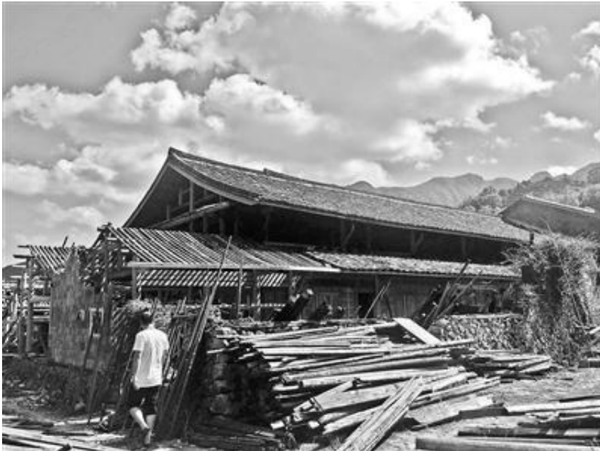
正在修缮的民居
