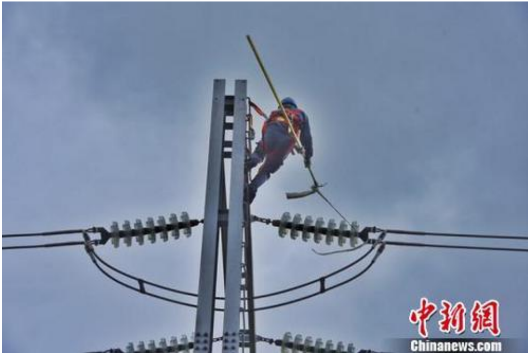
工作人员抢修在台风中受损的电力设备。通讯员摄
